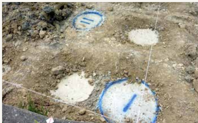
地盤補強「柱状改良」の様子
