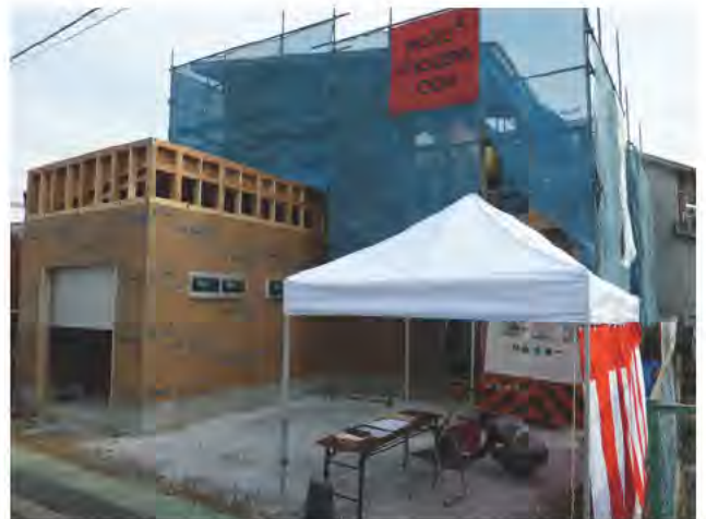
施工中のお宅
